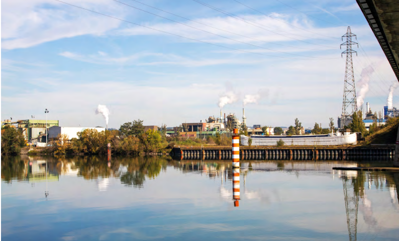
Le port fluvial sur le canal du Rhône. Un atout majeur pour le projet.
