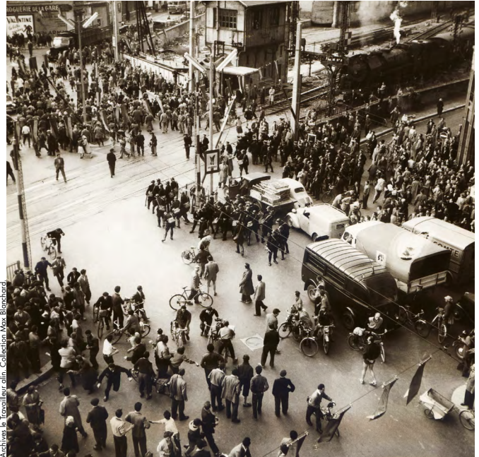
18 mai 1956, passage à niveau du cours Berriat, au sud de la gare. Ce que l'on a appelé plus tard « la conduite de Grenoble ».
